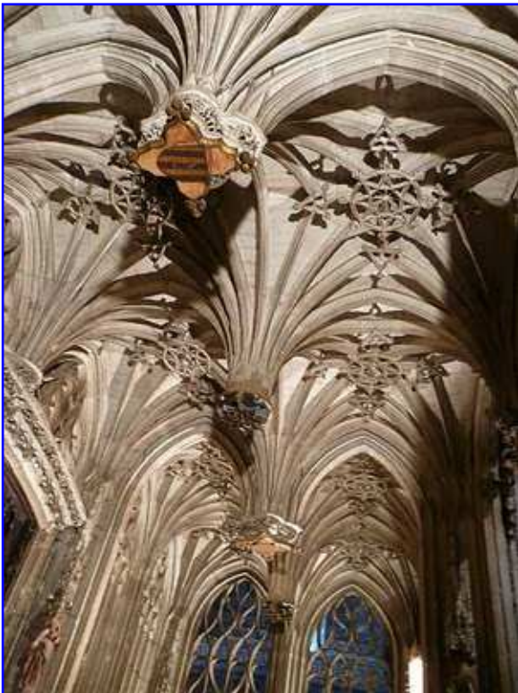
Santa Cecilia. Jubé. Detalle de las bóvedas pinjantes.
