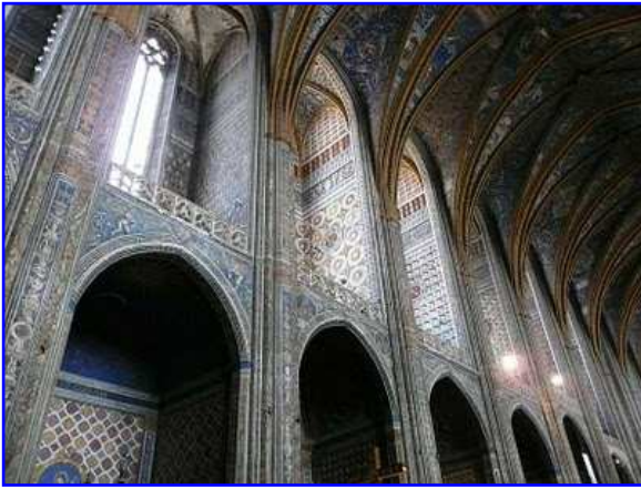
Santa Cecilia. Muro interior norte y bóvedas de crucería.
