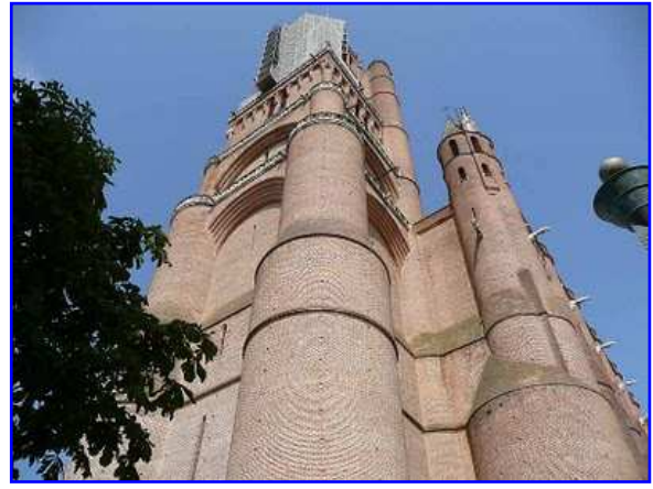
Santa Cecilia. Fachada oeste.
