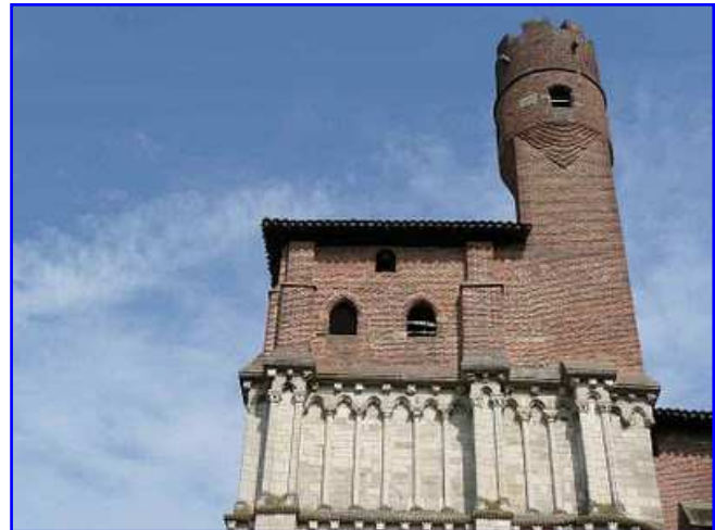
Detalle de la torre norte de la colegiata de San Salvy.
