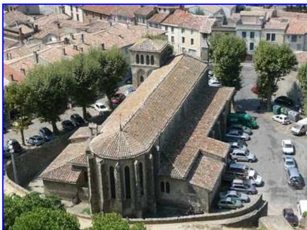
Bastida de San Luis. Iglesia de San Gimer vista desde el castillo.
